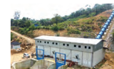
トンガル水力発電所
