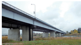
新荒川大橋補修
