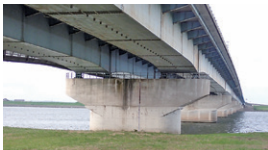
利根川橋耐震補強
