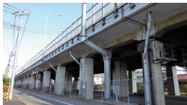
府中高架橋改良
