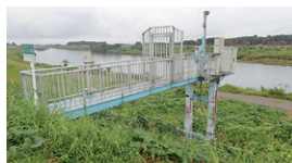
下館管内排水樋管無動力化
