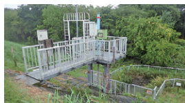
下館管内排水樋管無動力化
