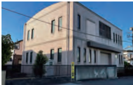
左敷田ポンプ場
