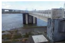
信濃川取水塔
