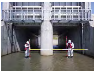
内川流域揚水機場修繕設計他業務
