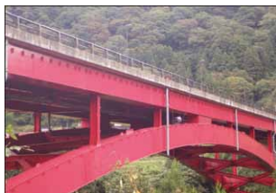
一般国道471号外藤橋外橋梁定期点検(レベル1点検)業務
