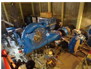
湯谷川小水力発電施工監理業務
