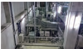
犀川左岸流域下水道 処理場整備工事
