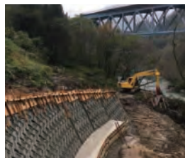
管理用通路 施工状況
