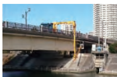
浦安市橋梁長寿命化
