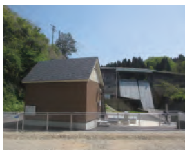
平沢川小水力発電所
