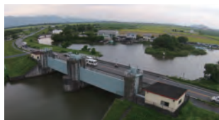
琵琶湖草津・守山地区水門
