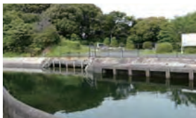
二川調節堰小水力発電
